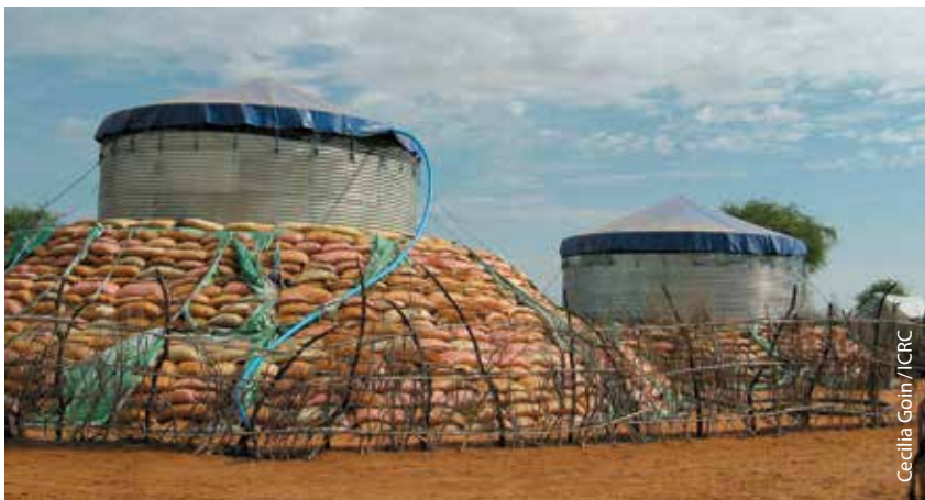
Rajah 18 Kemudahan penyimpanan air kecemasan
