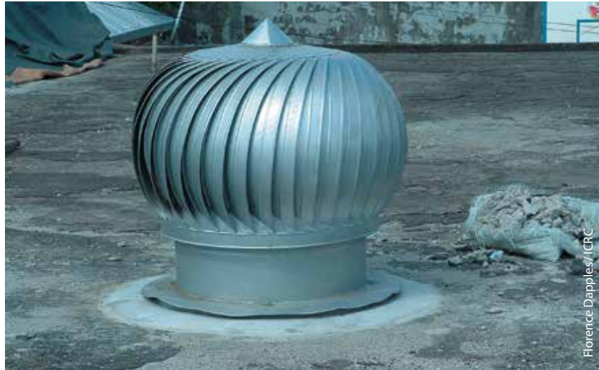
Rajah 11 Contoh sistem pengudaraan bubungan yang ringkas membenarkan penyedutan keluar udara panas dan lembap
